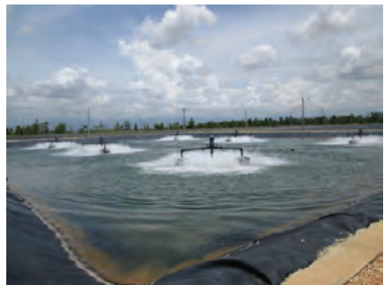
บ่อบำบัดน้ำเสียรวม (โรงงานลำดับที่ 101)
